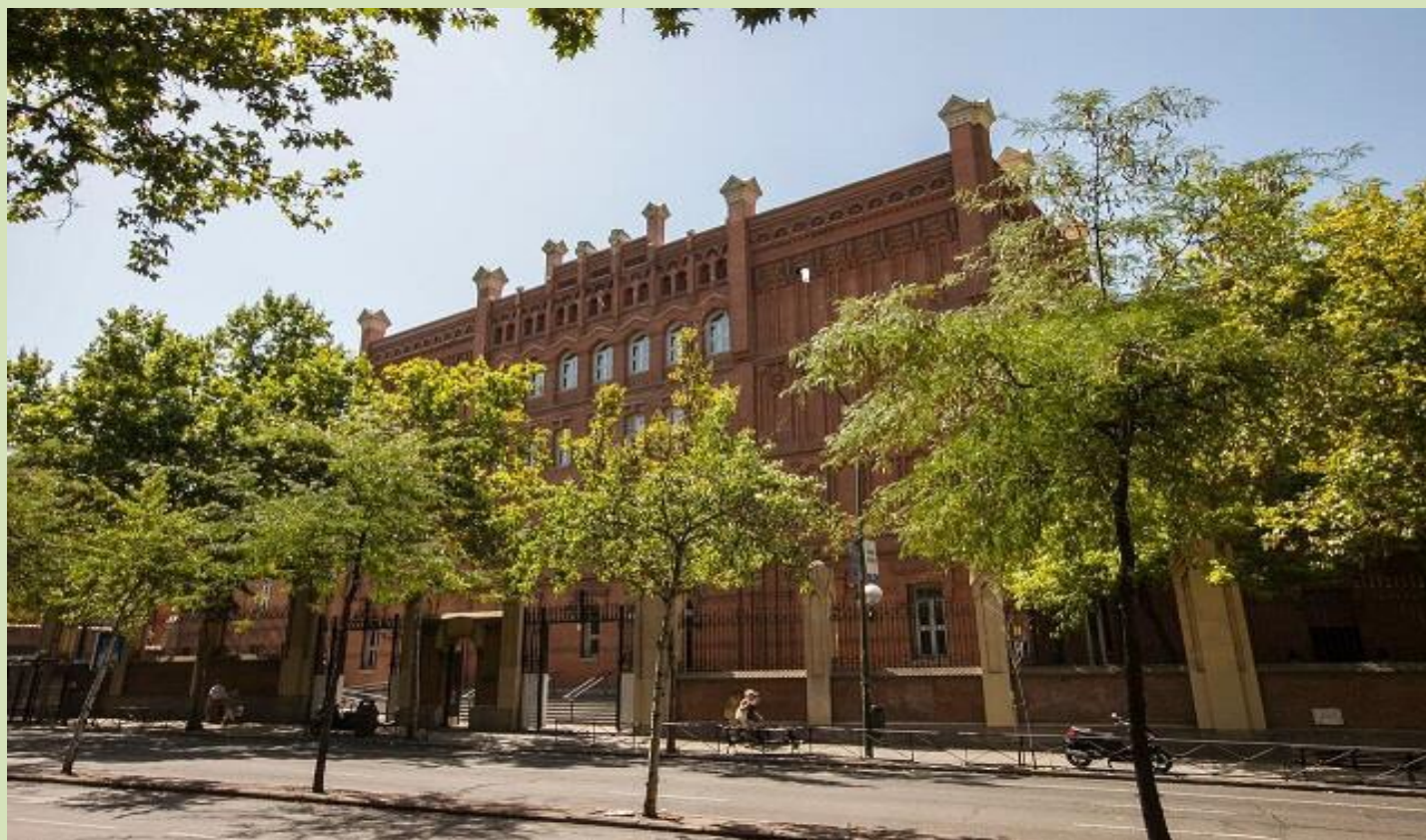
Edificio Alberto Aguilera
